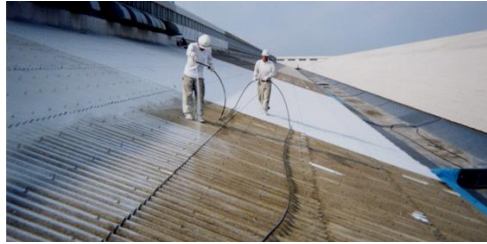
シラスバブルーンを主剤にした 厚膜型 遮熱断熱塗材 商品名【シポテックス】絶賛！販売施工中
